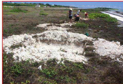
图3 人工填筑的钙质土地基
