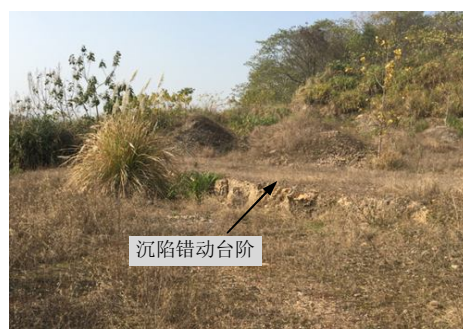
图 21 沉陷错动台阶 Fig.21 Subsidence faulting step
