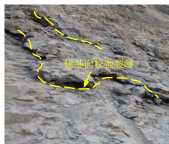
(b) 坝基表面局部松弛膨胀裂缝
