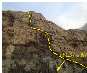
(a) 坝基下游 LS3320 表面裂缝
