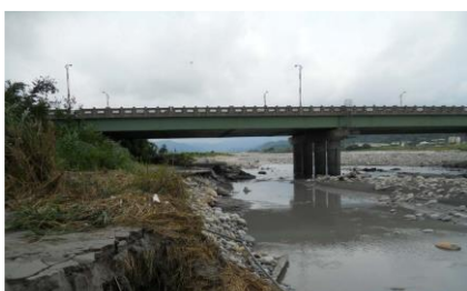
图 19 河岸冲刷 Fig.19 Riverbank scour
