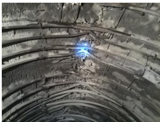
图 4 左洞护拱严重变形
