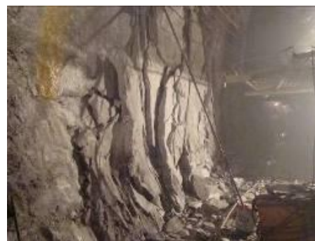
图6 锦屏二级水电站 2#引水隧洞埋深 1 800 m 洞段北侧边墙片帮
