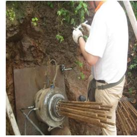
图 9 锚索张拉施工图
